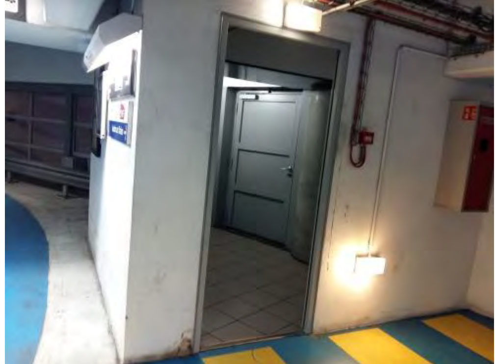
Accès à la station par des sas limités par deux portes pleines
